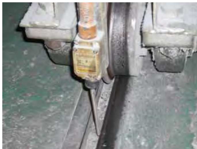
写真2 トラバース(台車)のリミッター
