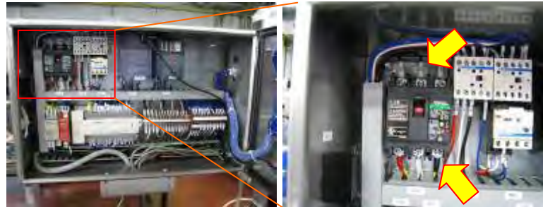
図 13. 操作盤内の電氣的危険源
