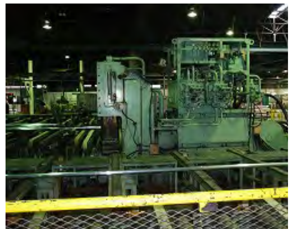
⑤後面設備（ストレッチャー -2）
