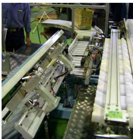
図 3-3 作業場 ここで製品整列用のパーツな どを交換する。
