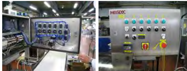
図 14. 操作盤扉の電氣的危険源
