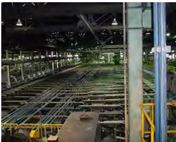
④後面設備（後面設備全体）
